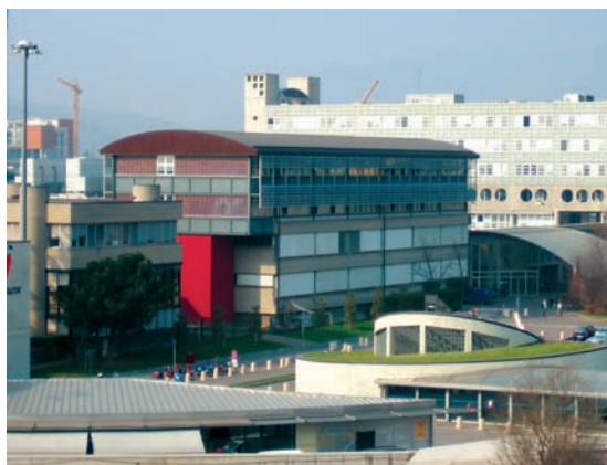
Fig. 6 - L'edificio della Facoltà di Medicina e Chirurgia della Università di Brescia Le building de la Faculté de Médecine et Chirurgie de l'Université de Brescia
